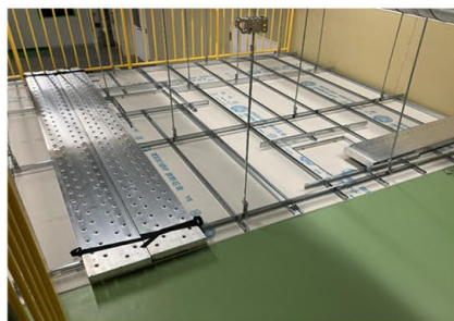
天井裏での安全作業体感
